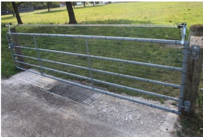
Abbildung: drei mechanische Untergrabschutzvarianten (von li nach re, Betonspaltenboden, Gummimatten und befestigter Betonbruch) sowie eine Elektrifizierung als Überkletterschutz. Um ein Passieren der Querstreben zu verhindern, werden diese zusätzlich mit Knotengitter abgespannt. (© Dr. Mendel)
