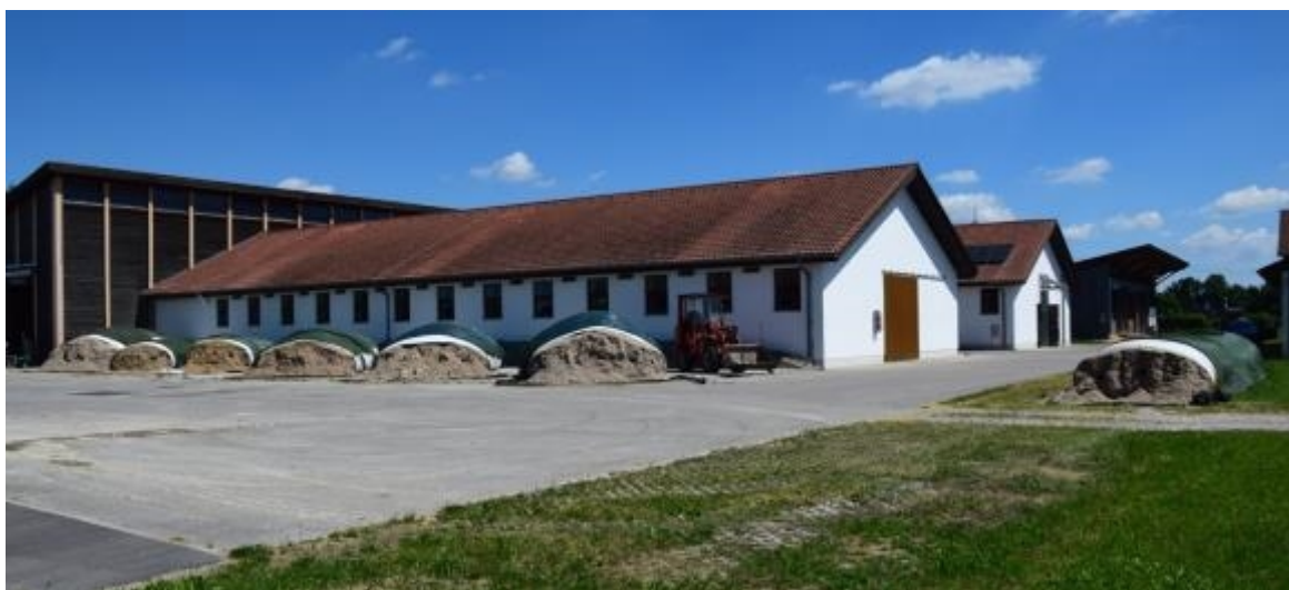
Abb.: Geöffnete Pressschnitzelsilageschläuche mit gleicher Öffnungsrichtung (Westen)
