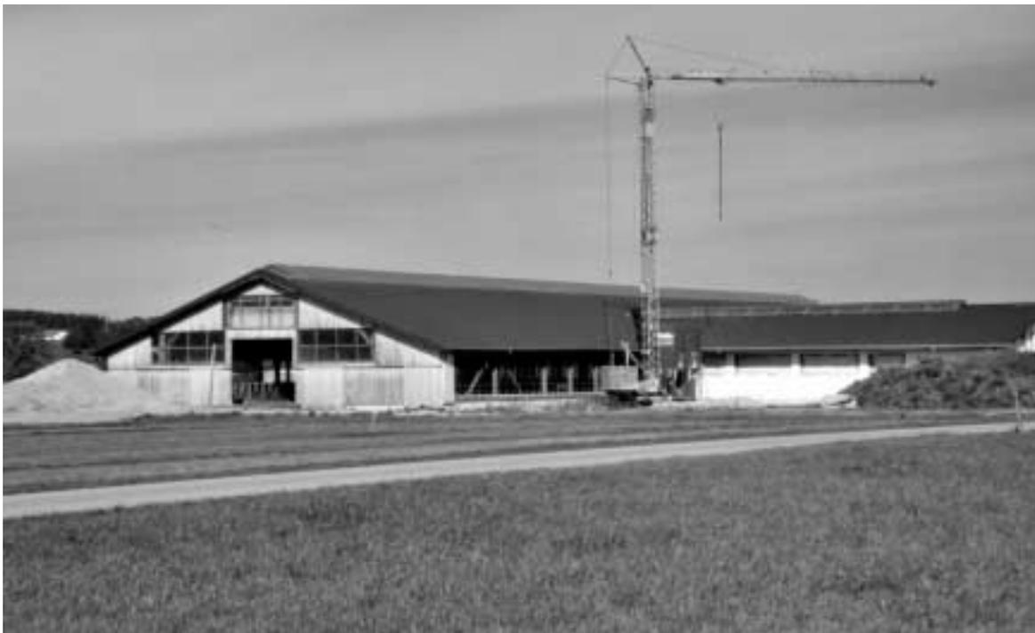
Abb. 1: Außenklimastall für Milchvieh und weibliches Jungvieh, Curtains an den Stalllängsseiten, mittig angebautes Melkhaus mit Warteraum, Spaltenboden mit Schrägschlitz
