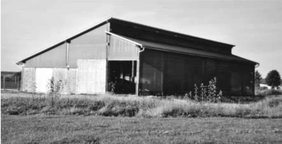
Abb. 2: Außenklimastall für Milchvieh, einhäusige Lösung mit Sheddach und Windschutznetzen an allen Seiten, integrierter Melkstand und Spaltenboden
