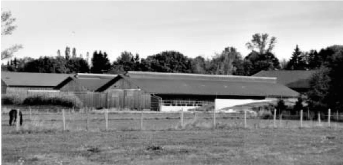
Abb. 4: Außenklimastall für Milchvieh und weibliches Jungvieh, zweihäusige Lösung mit Sheddach, integriertem Melkstand und planbefestigtem Laufbereich mit Schieber, Außenboxen für das Jungvieh (s. Vorderfront des Stalles)
