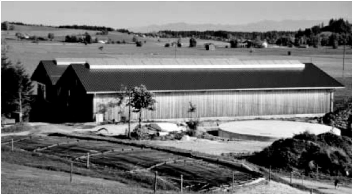
Abb. 3: Außenklimastall für Milchvieh und weibliches Jungvieh, zweihäusige Lösung mit Lichtfirst, integriertem Melkstand und planbefestigtem Laufbereich mit Schieber
