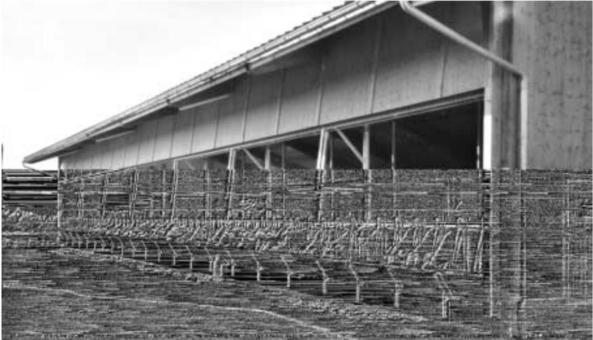
Abb. 5: Außenklimastall für Milchvieh, einhäusige Trogstalllösung (Lichtfirst, integrierter Melkstand, planbefestigter Laufbereich mit Schieber), Längsseite mit vertikal schließenden Toren
