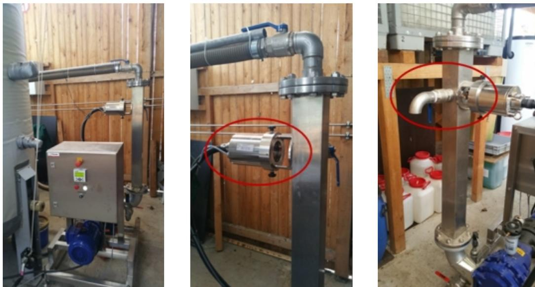
*Externe Pumpe mit Loop zur Zirkulation des Fermentersubstrats und Nah-Infrarot-Sensor zur Spektrenerfassung mit Probenahmehahn*
