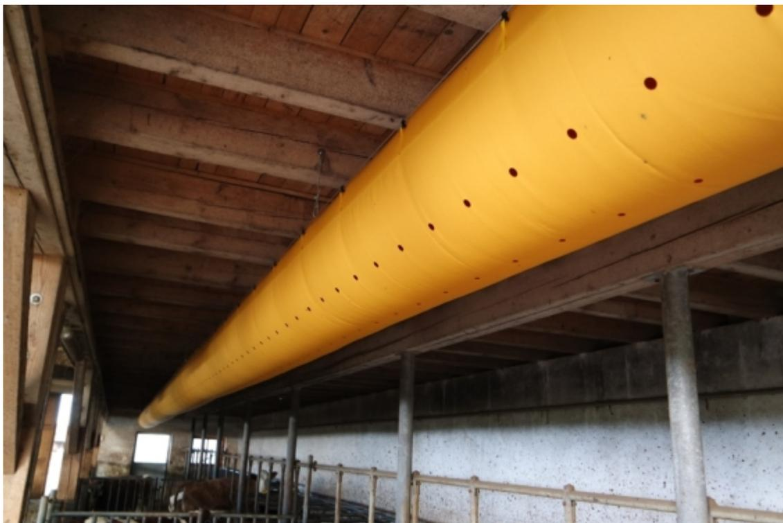
*Schlauchlüftung in einem Jungviehstall*
