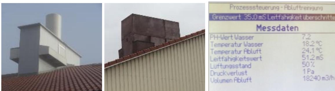
*Abluftfilter mit Wärmetauscher (links: BJ 2014);
