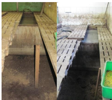
Unterschiedliche Füllstände in den Güllekanälen unterhalb einer Bucht
