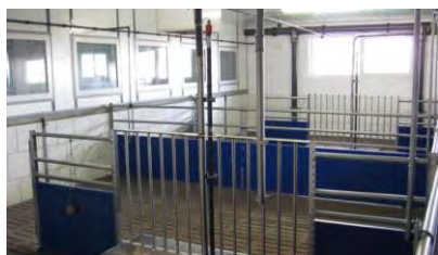
Mastabteil mit Schadgasmessung
